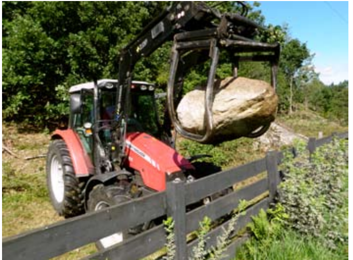
Olav Aabel med traktoren løfter steinen på plass.
